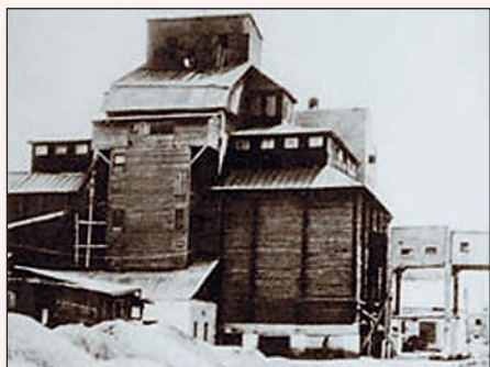
Деревянный элеватор нового «сибирского» типа, построенный в 1930-е годы без единого гвоздя в городе Камень-на-Оби Алтайского края по проекту Ю. В. Кондратюка. «Мастодонт» сгорел в середине 1990-х гг.
